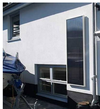
Exempel: Källartaket är ovanför marknivån
