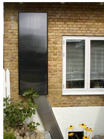
Exempel: En monterad extra förlängningssats för källare med en Alu-skyddskåpa.
